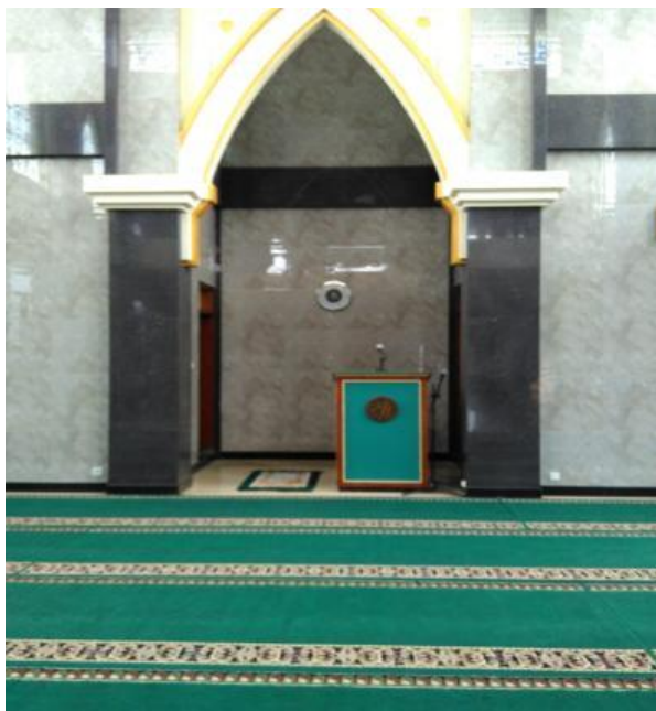
Gambar 6. Dinding atas mimbar di tengah proses renovasi (rencananya akan dilukis kaligrafi kembali)
