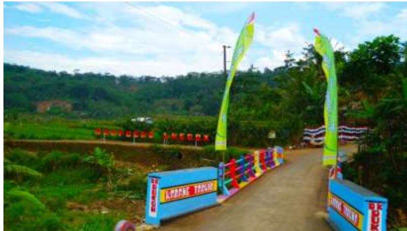
Gambar 5. Mengecat jembatan yang dilakukan oleh anggota komunitas.
