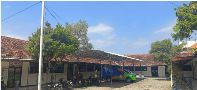
Gambar 1. Tampak Depan Perpustakaan Daerah Ponorogo Sumber: Dokumentasi Peneliti, 2025
